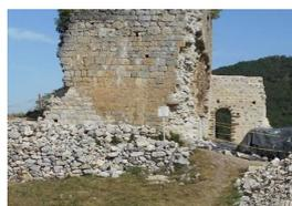
En 2018 les travaux porteront sur la mise en sécurité du haut de la tour et la consolidation de la façade Nord en fonction des pierres de parement disponibles.
